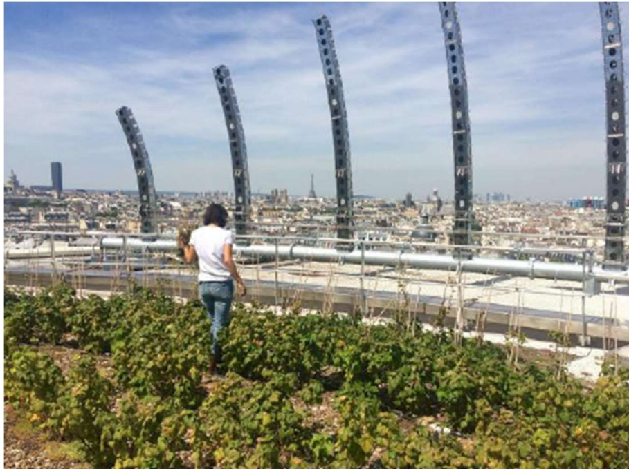
オペラ・バスティーユの屋上緑化（ADIVET: 緑のファサードとトワチュール協会）
