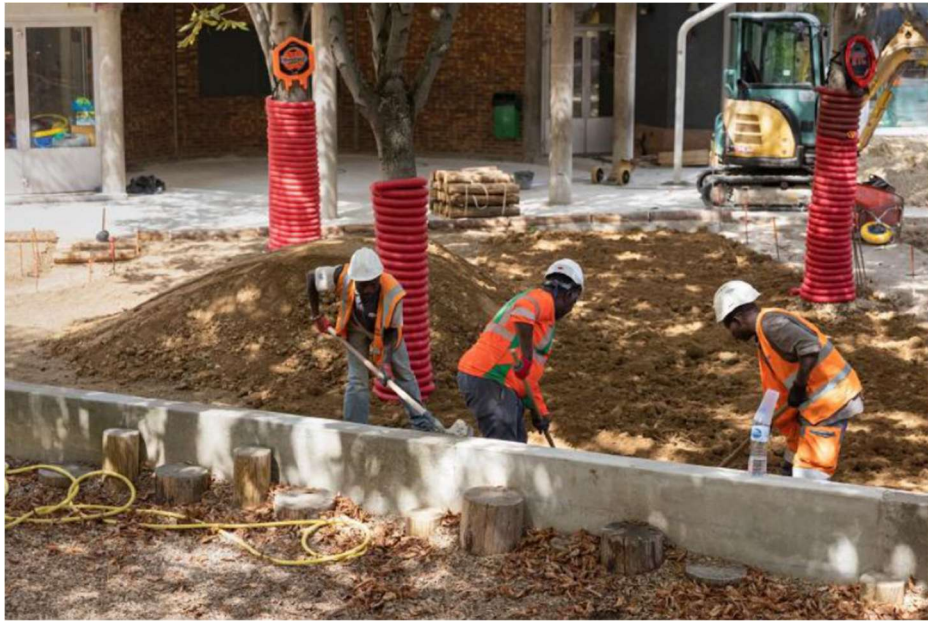
2022 年 7 月、パリ 15 区エメリオ小学校の中庭で行われた土木工事（撮影：ギヨーム・ボンタン／パリ市）
