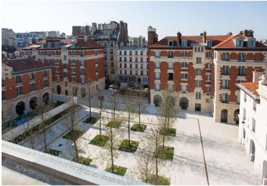
マレ地区にあるミニム兵舎（La Caserne des Minimes）は、ELOGIE-SIEMPによって改修された社会住宅。（クレジット：Joséphine BRUEDER / パリ市）
