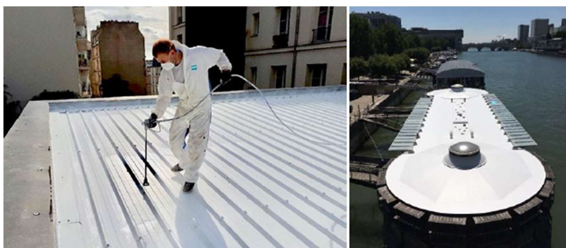
11 区、ベルモン体育館への耐熱塗料の塗布、13 区、アダマン病院はしけへの耐熱塗料の塗布。
